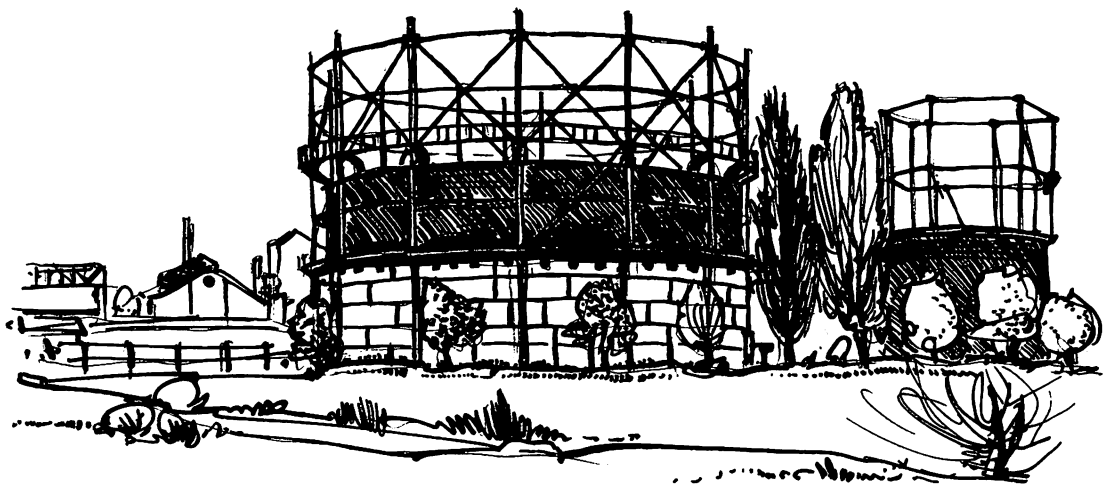
Alte Gasbehälter an der Werrestraße
